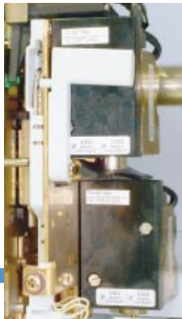
Provozní spouště: Vypínací, zapínací a podpětová.
