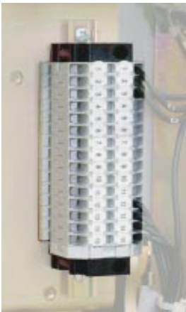
Svorkovnice pomocných obvodů vypínače
