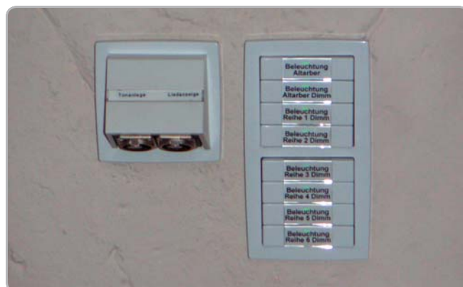
Ovládání svítidel v kostele v Ambergu z prostoru vstupu ze sakristie
